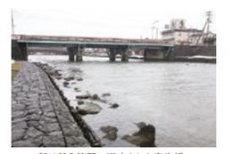
状況や交通への影響などを、総合的に判断します。例えば、実生橋は、建設後84年が経過し、再度、補修することが経済的なくなるほど損傷が進んできたこと、架け替え時に迂回路となる道路の整備が完了する目処もついたことなどから、架け替え箇所に選定しました。 県は、規模が大きい事業に新規に着手しようとする場合、透明性と客観性の確保の観点より、有識者で組織する「公共事業評価監視委員会」から意見を聞くことになっています。この実生橋は、令和2年12月2日の同委員会において審議され、「事業実施が妥当である」との意見をいただきました。よって、令和3年度当初の予算編成作業に取り組みます。
